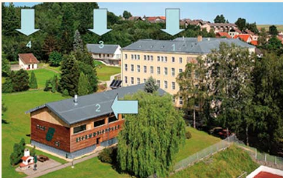
Gebäudeübersicht, Ansicht vom 29.07.2008 Quelle: Firma Rheinzink
