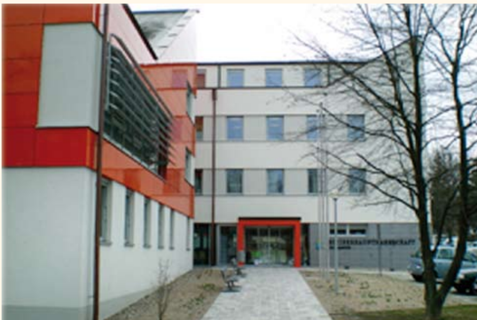
Amtsgebäude nach der Sanierung Quelle: Macho
