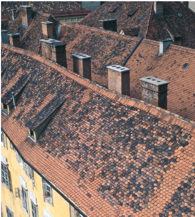
Diese prominente Dachfläche der "Alten Post" am Grazer Schlossbergplatz wurde inzwischen bedauerlicherweise durch neues Deckungsmaterial ersetzt.
