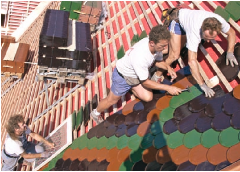
Klosterneuburg, Stiftskirche. Das Muster wird nach einer Planzeichnung gelegt.
