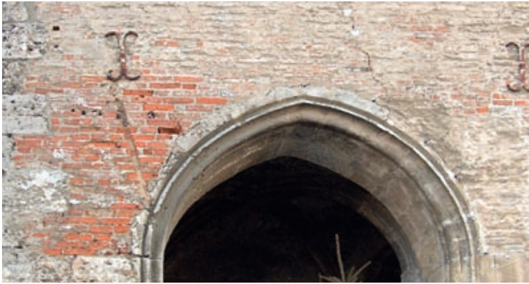
Krems, Gozzoburg vor der Restaurierung, Arkade mit Ziegelmauerwerk aus der Mitte des 13. Jhs., Detailansicht
