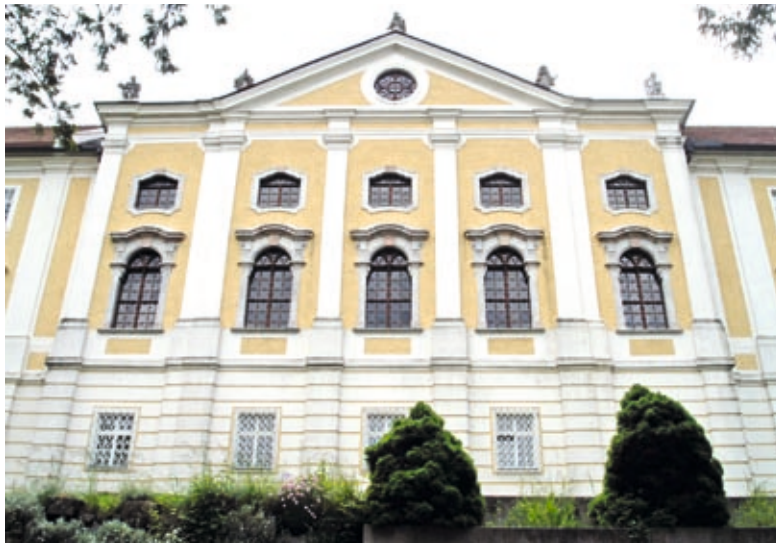
Stift Seitenstetten, Mittelrisalit des Nordtraktes
