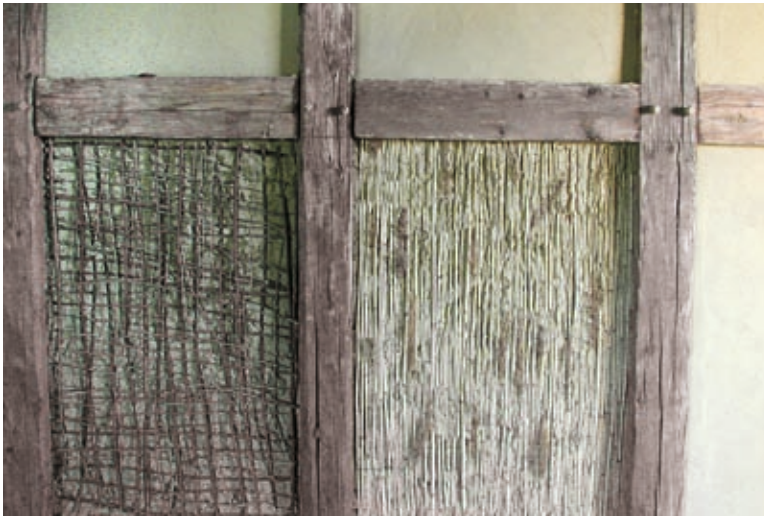
Archäologischer Park Carnuntum, Holzständerkon- struktion mit Lehm- ausfachung in einem modellhaft rekon- struiertem römischen Wohnhaus des 4. Jhs. n. Chr. (2006)
