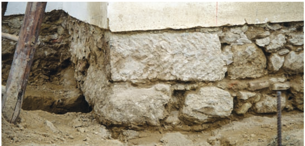
Radlbrunn, Brandlhof, Mauerfuß aus Natur- steinmauerwerk
