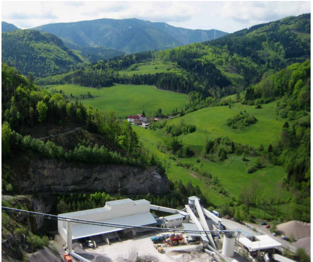
Bezirk Lillienfeld, Ansicht des Steinbruchareals mit Siedlungsgebiet Richtung Süden
