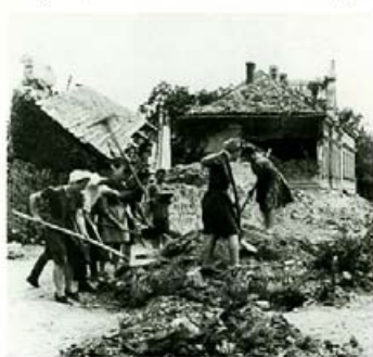
Schutträumung Pleyergasse, Wk. Neustadt 1946
