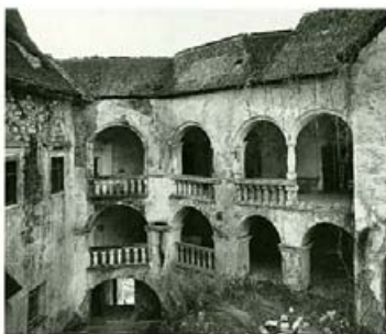
Schloß Plankenstein im November 1955 nach dem Abzug der Besatzung. Erst 1982 wurde die Restaurierung durch den neuen Besitzer abgeschlossen
