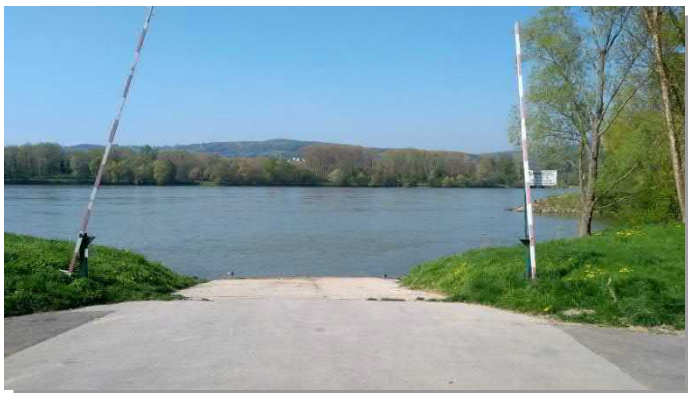
Sliprampe (direkt in die Donau)
