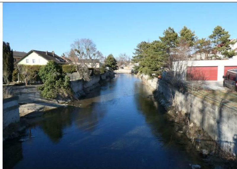
Fotostandort Oberwaltersdorf, Brücke B210 über die Triesting, Blickrichtung flussabwärts
