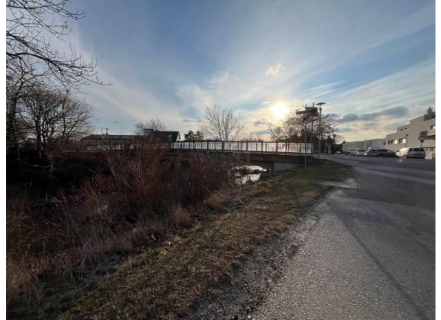
Dr-Karl-Renner-Haus, Blick auf Brücke B16, Münchendorf
