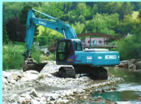
Bauliche Maßnahmen zur Risikominimierung im Hochwasserfall
