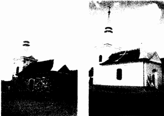
Kapelle in Gaidorf vor und nach dem Umbau (Weinviertel)
