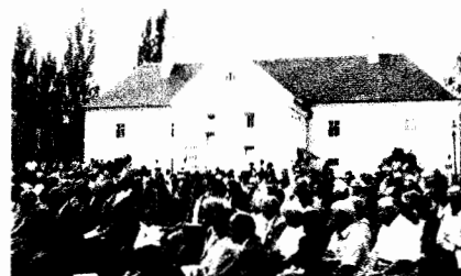
Tagesheim für Behinderte in Mühlbach vor und nach dem Umbau (Weinviertel)
