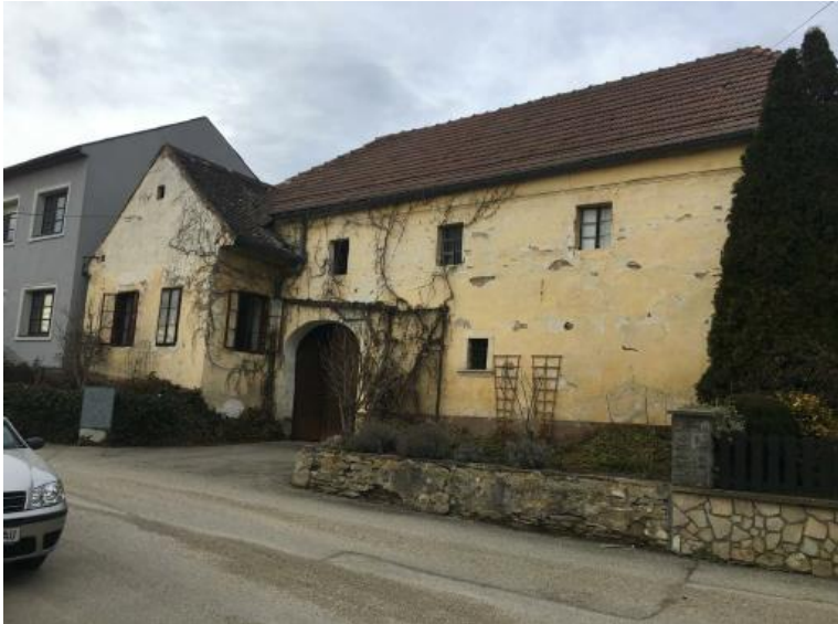
Abbildung 19: Straßenseitig Ansicht des Objektes Klein Meiseldorf 61 (Foto: Mag. Gschwantner)
