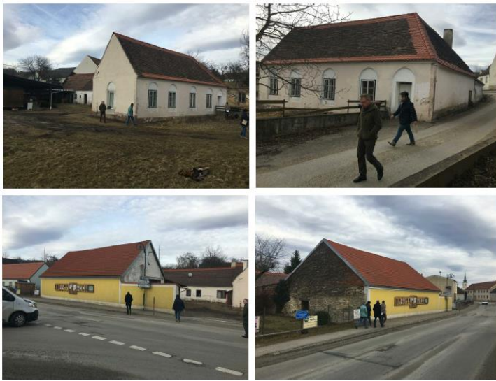
Abbildung 13: Fotos der Begehung des Objektes Meiseldorf 23 (Foto: Mag. Gschwantner)
