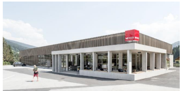
Abbildung 67: Beispiel Fassadengestaltung anhand einer M-Preis Filiale aus Altenmarkt (Architekturbüro nonconform, 2017)
