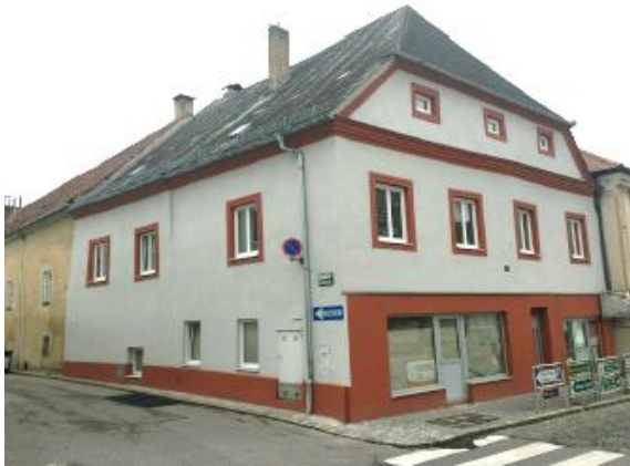
Abbildung 45: Foto des Gebäudes Kirchplatz 9 (Foto: Mag. Franz Gschwantner)
